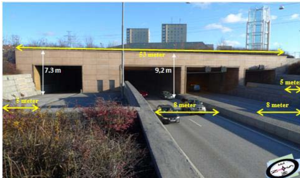
Figur 2. Södra länkens mynningar vid Årsta. Vägbanan ligger ca 9 meter under omgivande markplanet.
