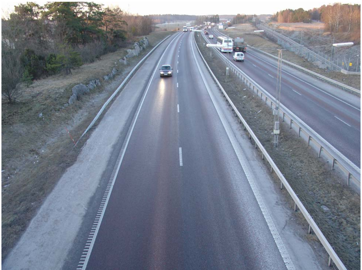
Figur 11. CMA behandlad vägbanan längs motorvägen mellan Stockholm och Arlanda.
