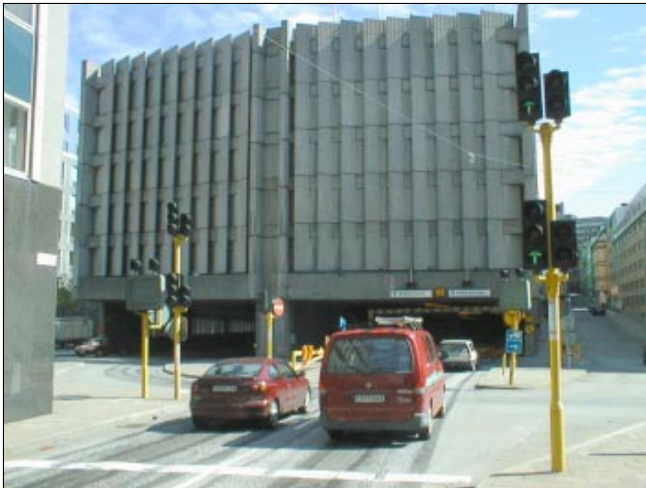
Klaratunnelns in-och utfarter vid Tegelbacken
